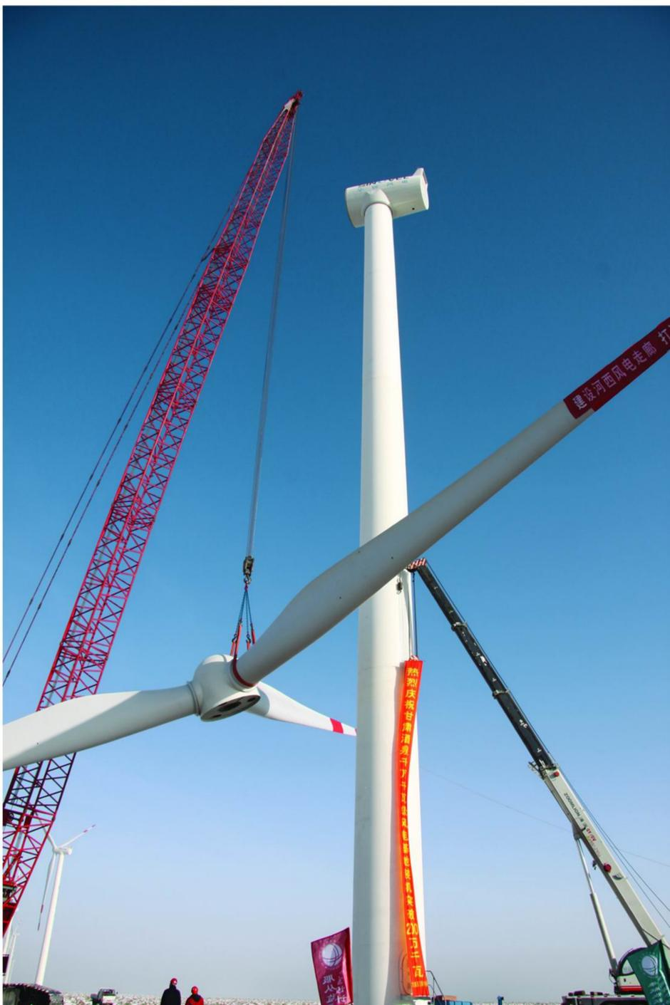
大型国产风机在玉门风电场吊装
